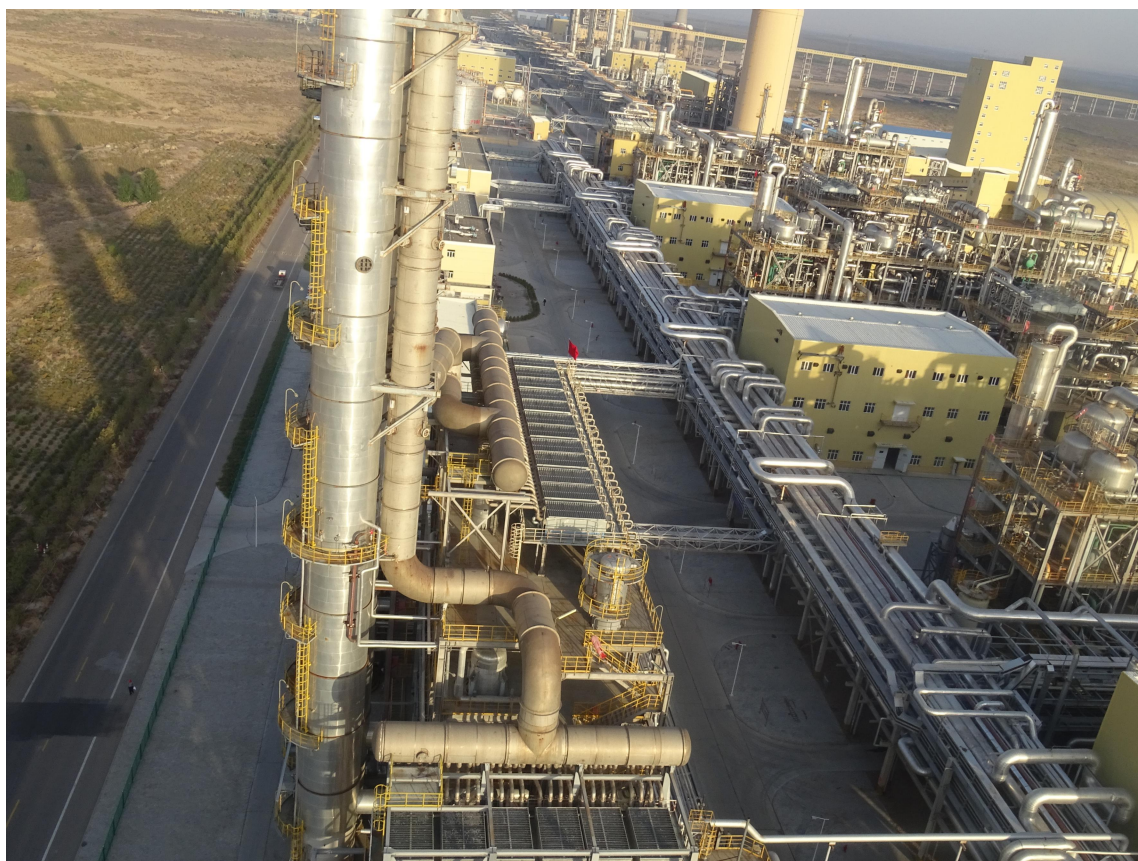
照片2-8独贵塔拉产业园（北区）鄂尔多斯市新杭能源有限公司60万吨乙二醇项目
